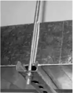
Крепление при помощи траверса и шпильки
