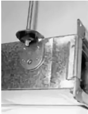
Крепление при помощи L-образного профиля и шпильки
