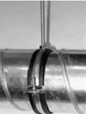
Крепление при помощи хомута и шпильки
